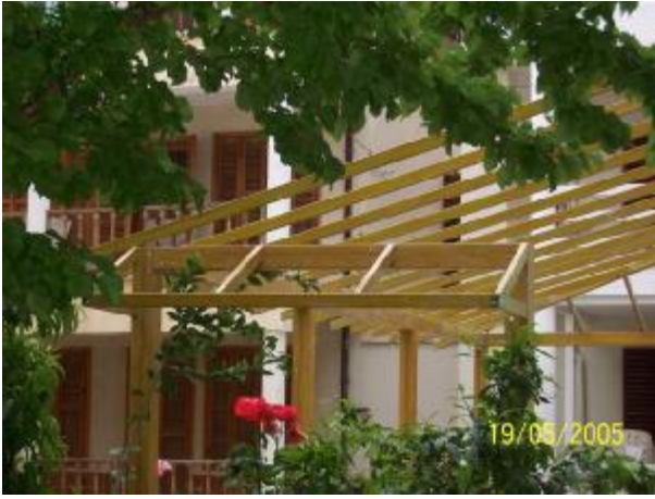
Kendinden desenli ahşap görünümlü kompozit profiller ile bir pergola uygulaması, Kuşadası 2005
