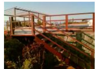
Kendinden desenli ahşap görünümlü kompozit profiller ile havuz kenarı korkuluk, teras ve merdiven uygulaması Maşukiye 2006
